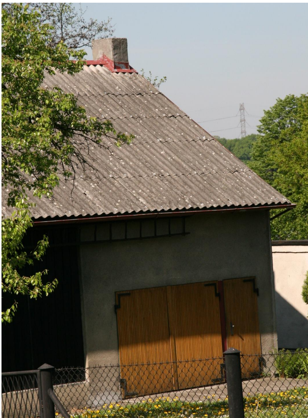
Rysunek 3 Dach pokryty płytami azbestowymi falistymi
