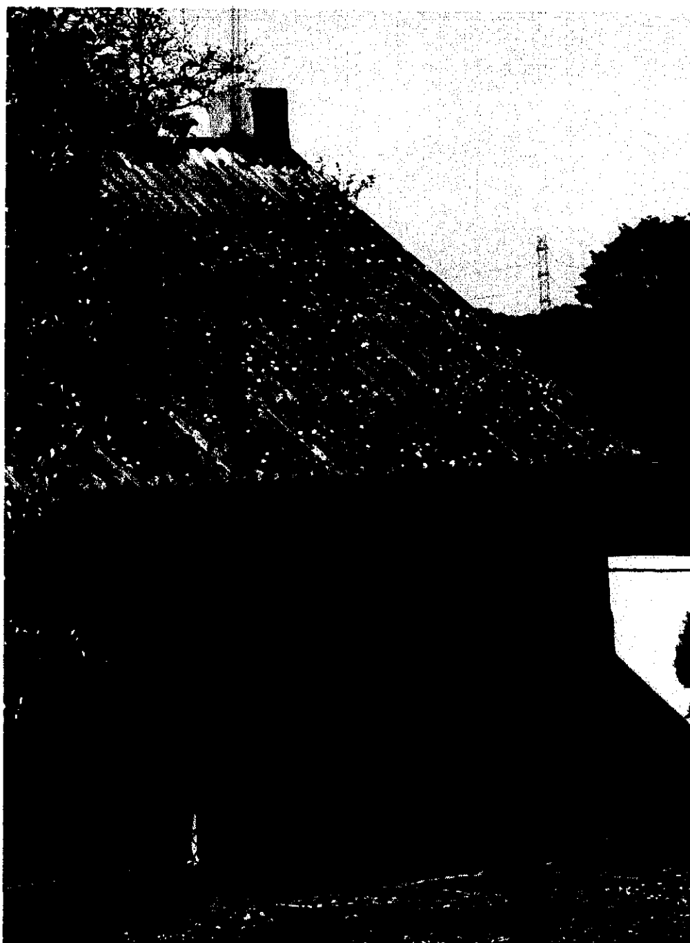
Rysunek 3 Dach pokryty płytami azbestowymi falistymi
