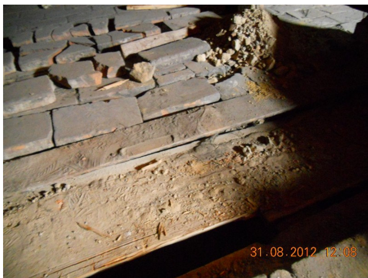
Zdjęcie Nr 13 – odkrywka nr 1 pas górny belki stalowej
