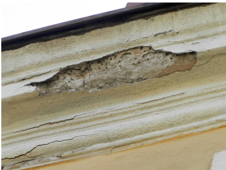
Zdjęcie Nr 30 – uszkodzony gzyms od strony boiska
