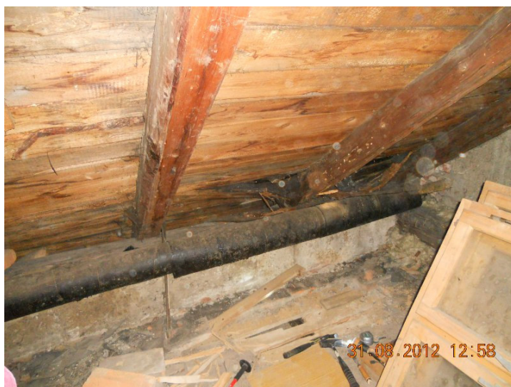
Zdjęcie Nr 16 – uszkodzenie dachu nad odkrywką nr 2
