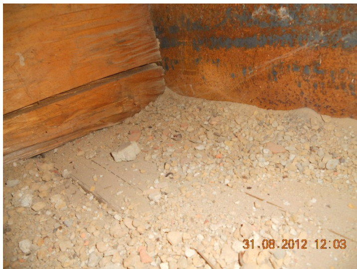
Zdjęcie Nr 14 – odkrywka nr 1 oparcie belki drewnianej na belce stalowej
