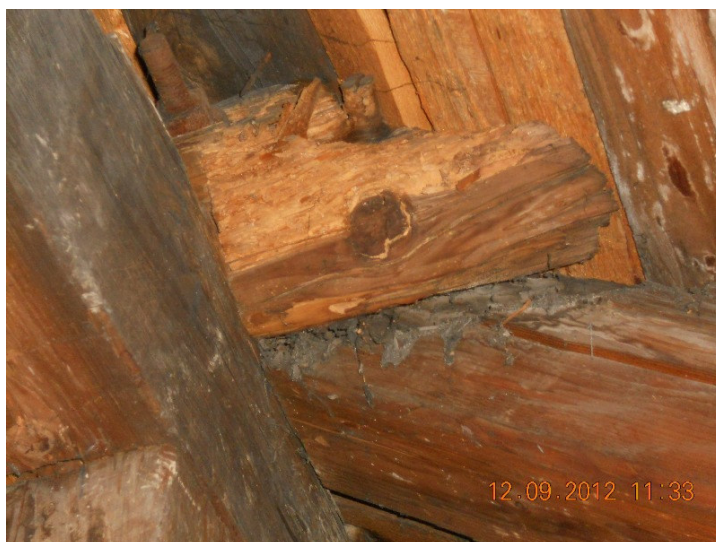
Zdjęcie Nr 26 – uszkodzona końcówka belki poprzecznej
