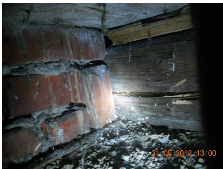
Zdjęcie Nr 15 – odkrywka nr 2 oparcie belki drewnianej na ścianie
