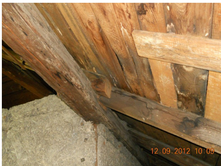
Zdjęcie Nr 23 – uszkodzona krokiew złącze na płatwi
