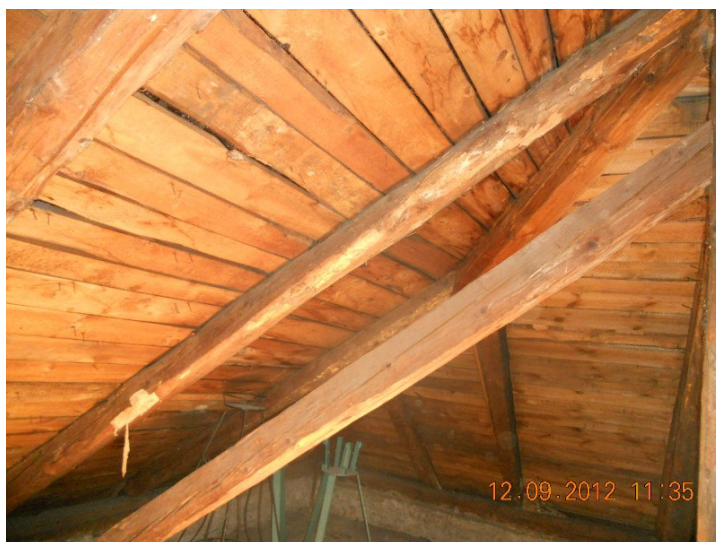
Zdjęcie Nr 28 – uszkodzona krokiew więzara pełnego
