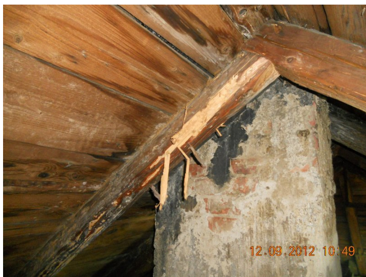
Zdjęcie Nr 25 – stryszek nad klatką schodową uszkodzona krokiew
