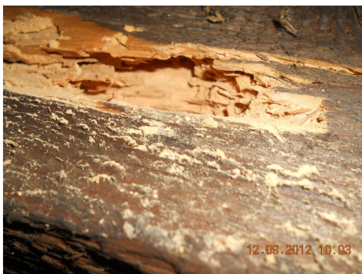
Zdjęcie Nr 22 – uszkodzona krokiew zbliżenie
