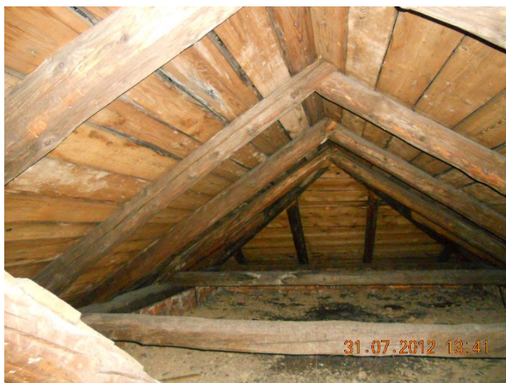
Zdjęcie Nr 10 – więźba w pasie klatki schodowej
