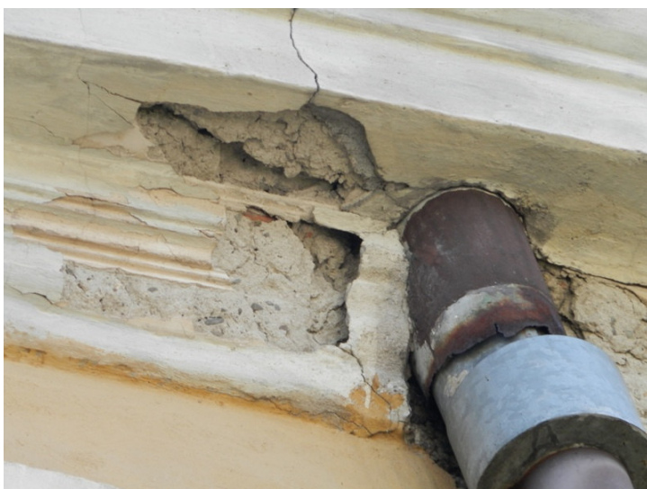
Zdjęcie Nr 29 – uszkodzony gzyms przy narożniku zachodnim
