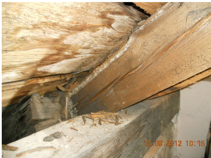
Zdjęcie Nr 24 – uszkodzona krokiew rozkład drewna w strefie murłaty
