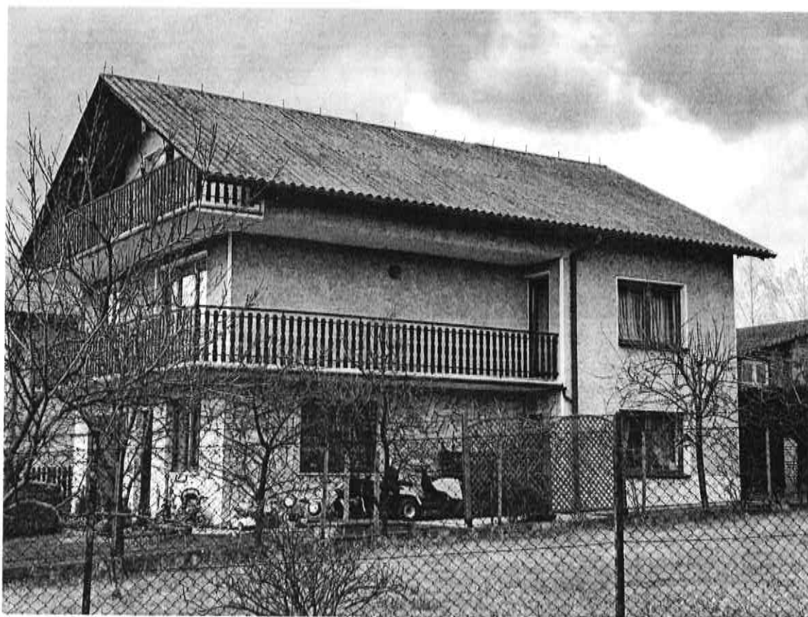
Rysunek 19 Wyroby zawierające azbest na dachu
