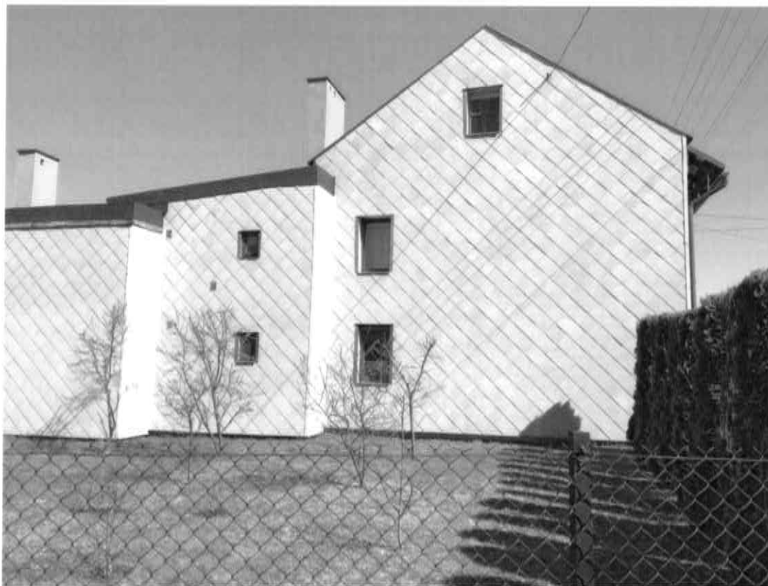
Rysunek 15 Wyroby płaskie zawierające azbest
