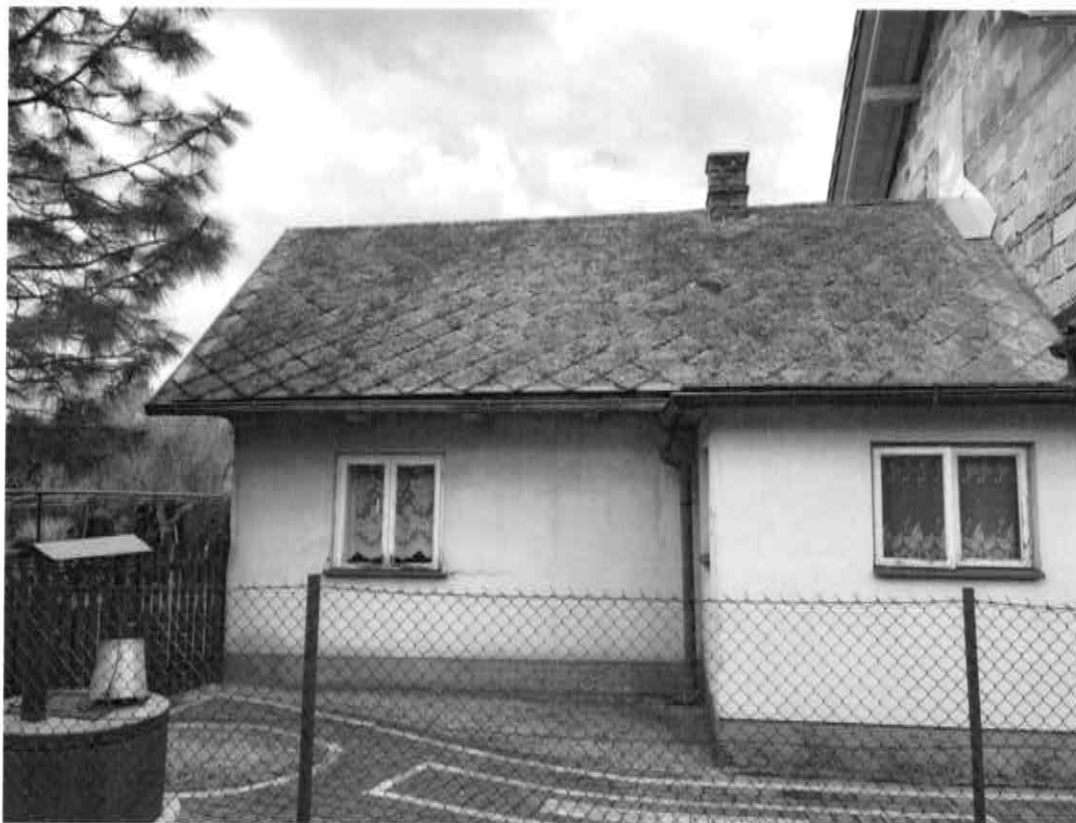
Rysunek 12 Wyroby zawierające azbest na dachu budynku mieszkalnego
