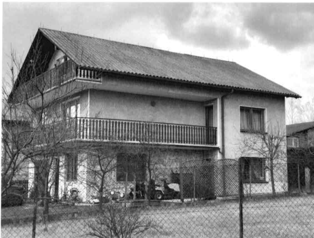
Rysunek 19 Wyroby zawierające azbest na dachu
