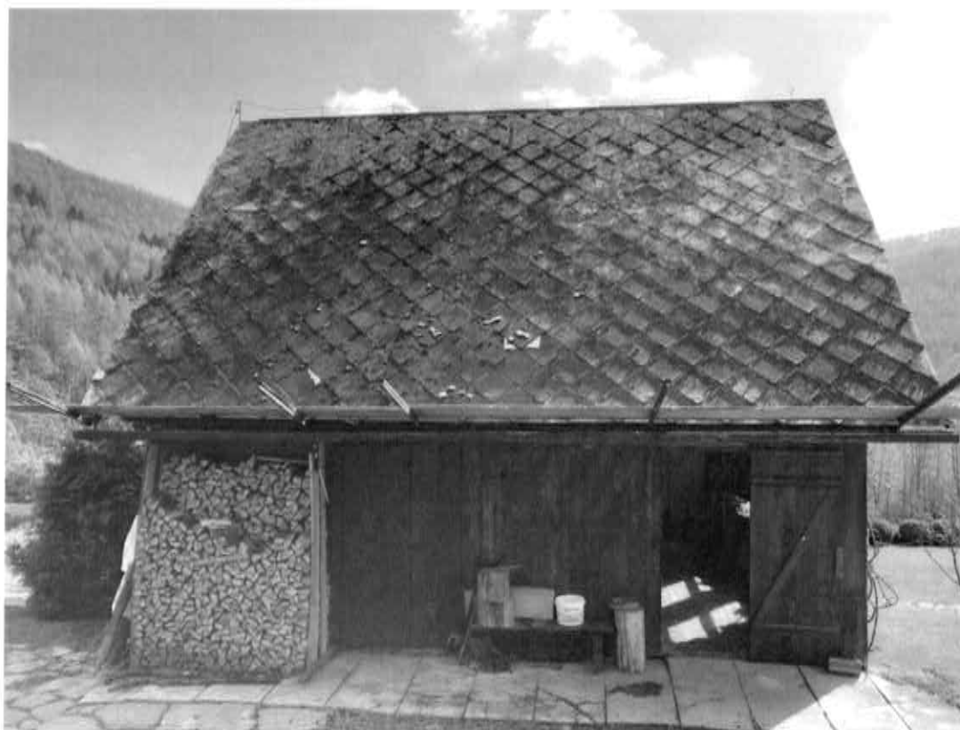
Rysunek 13 Wyroby zawierające azbest na dachu budynku gospodarczego
