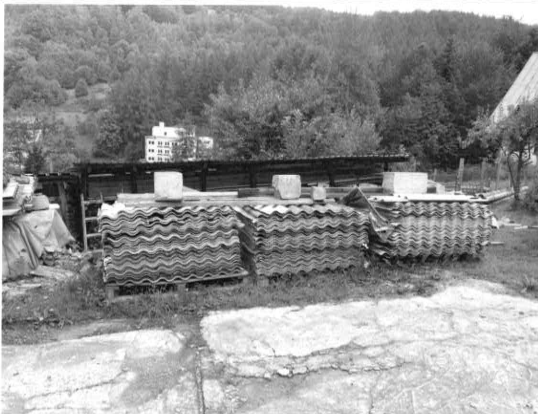
Rysunek 8 Wyroby zawierające azbest przygotowane do odbioru od mieszkańców
