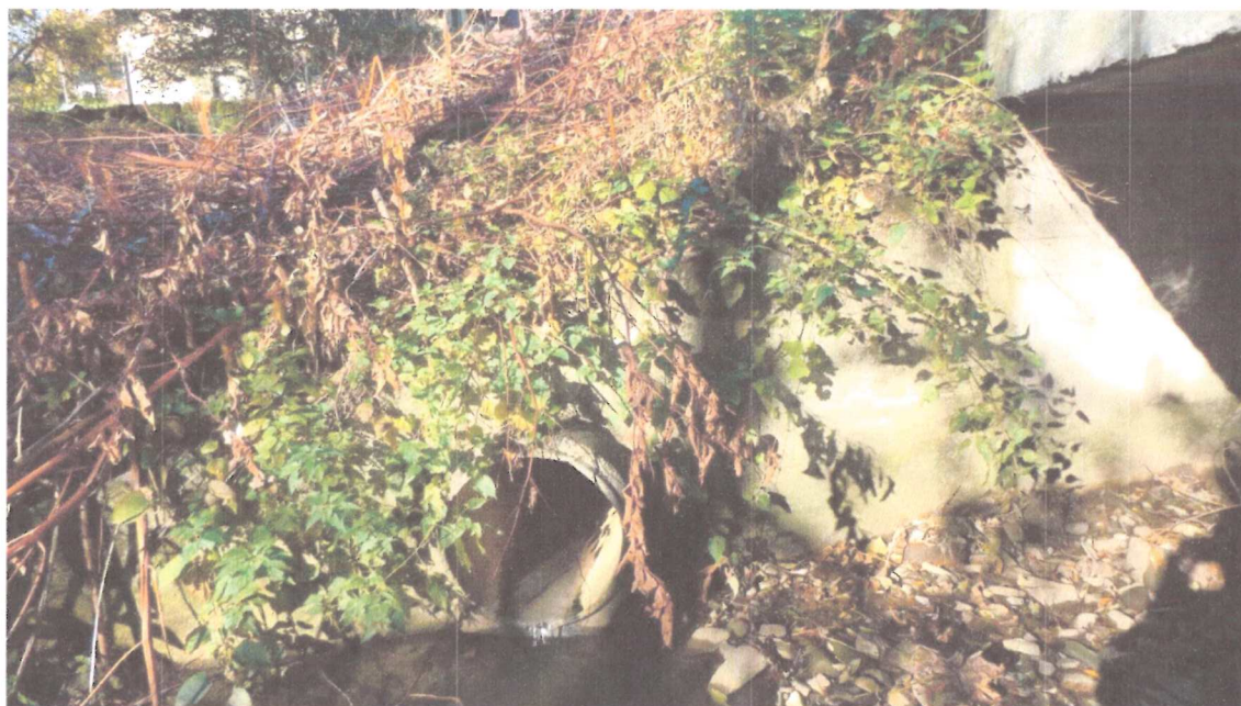
Fot. nr 8 Wylot rury kanalizacji w rejonie przyczółka na lewym brzegu, powyżej obiektu
