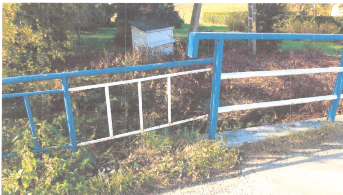
Fot. nr 4 Balustrada na obiekcie, widoczny brak połączenia przeciągów balustrady na dojściu do obiektu.
