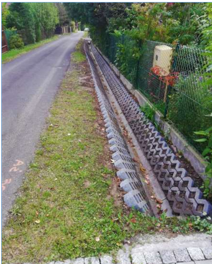
Zdjęcie 34. Droga Ogrodowa w sołectwie Grodziec – realizacja odwodnienia drogi z 2020 r.
