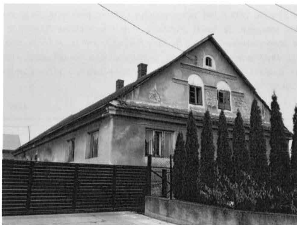
Dom nr 36 z 1844 r. zbudowany przez Jana Miklera prawdopodobnie d. karczka (rej. zab. A-168/76) ochrona prawna obejmuje całość obiektu i najbliższe otoczenie. Zachował oryginalną bryłę, przekształcone częściowo otwory okienne. Stan techniczny niedostateczny (zaniedbany, destrukcja ścian i elewacji). Obiekt wymaga podjęcia kompleksowego remontu, z miejscowym przywróceniem pierwotnej formy.
